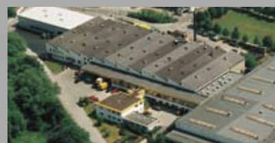
Siège social CMCO Europe usine et centre logistique Velbert - Allemagne
